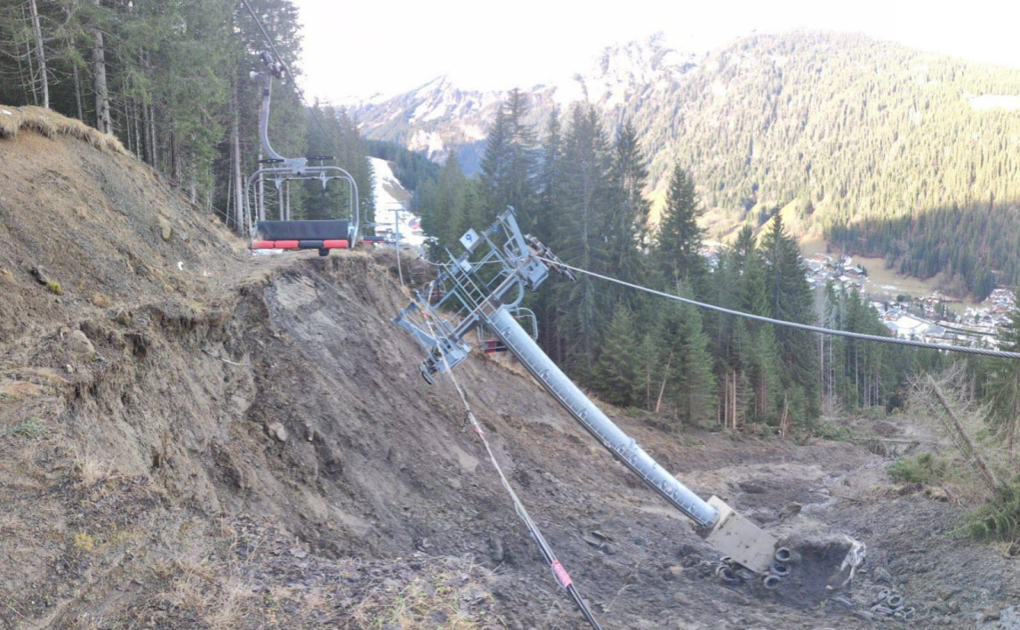
Glissement de terrain à Châtel qui a entraîné la chute d'un pilonne de télésiège, décembre 2022
