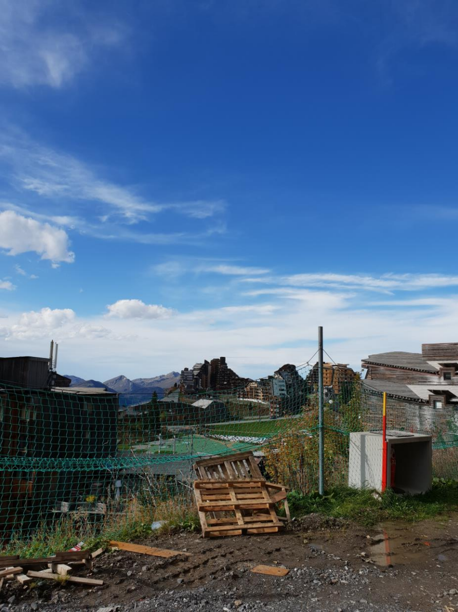
Travaux d'entretien à l'inter-saison dans les stations, ici Avoriaz
