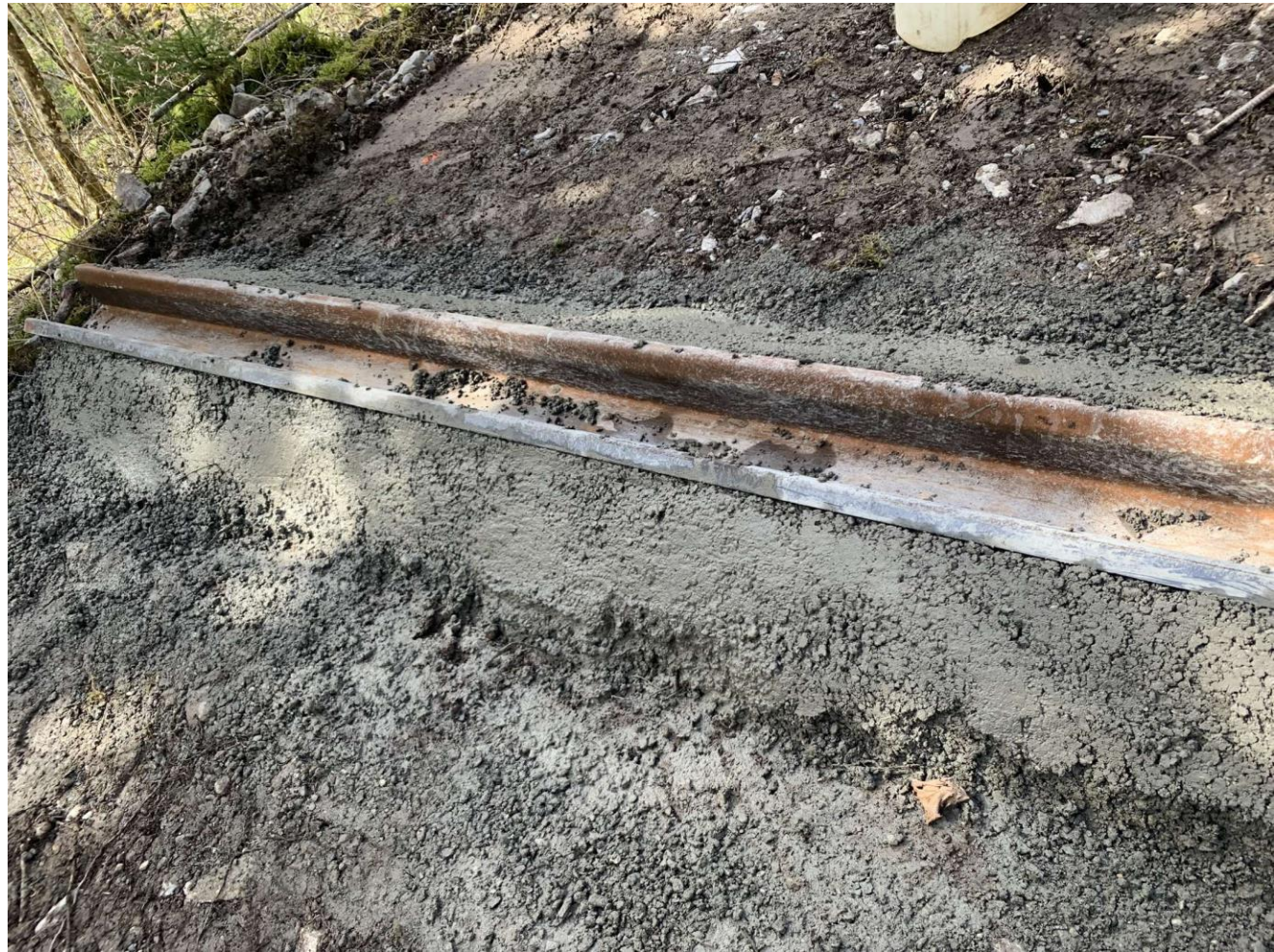
Installation d'un renvoi d'eau dans un chemin vers Vailly
