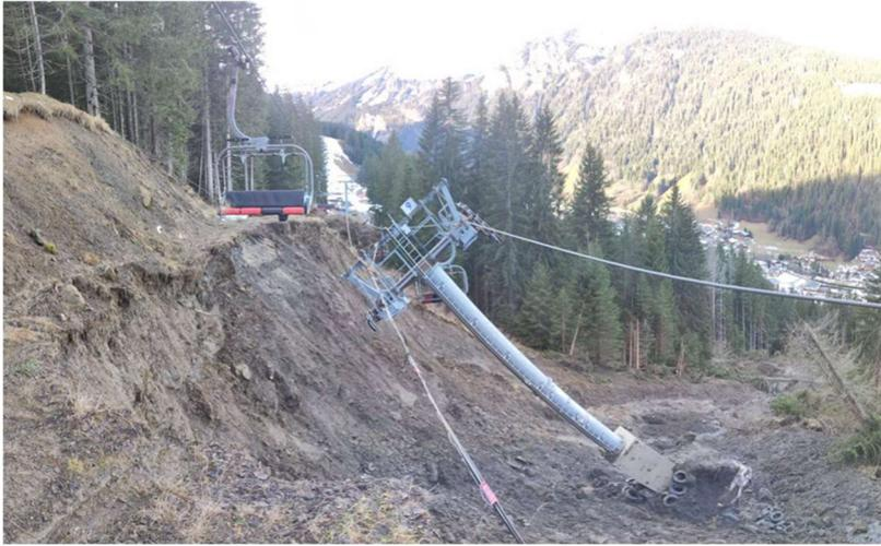
Photo 21 : Chute d'un pylône de télésiège Châtel en décembre 2022 suite à un glissement de terrain
