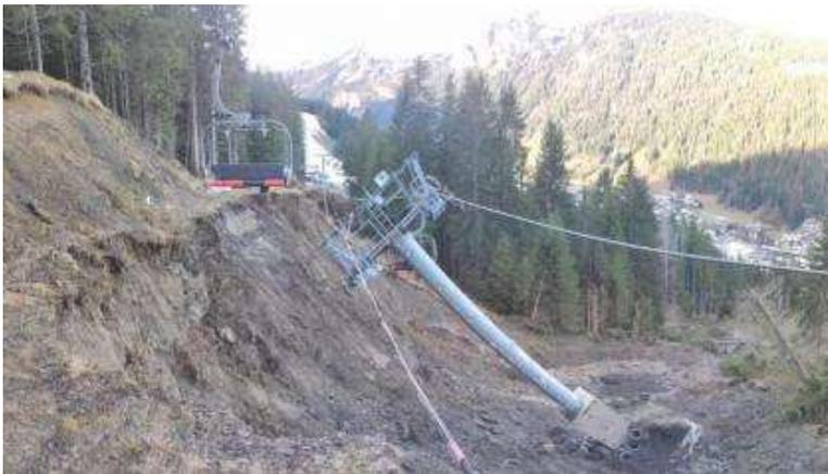
Photo 5 : chute d'un pylône de télésiège à Châtel en décembre 2022
